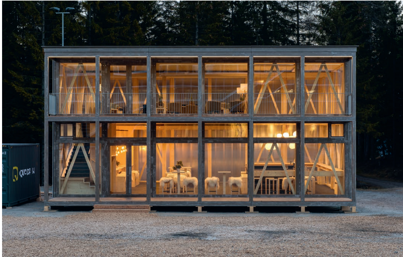
Der Modulbau Quadrin Event feierte an der Eröffnung des Nordic House der Biathlon Arena Lenzerheide seine Weltpremiere. Aufbau und Ausbau dauerte je einen Tag.
