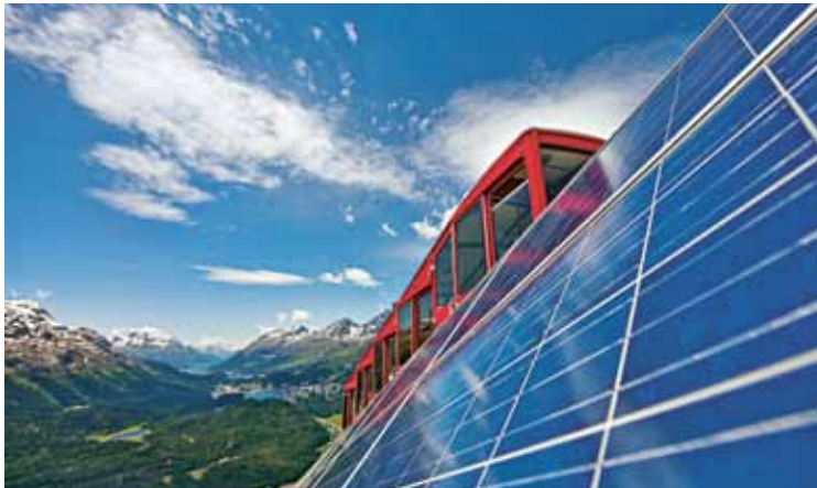
Die Sonne brings: nicht nur dank Kollektoren und Solaranlagen am Hotel. Bereits entlang der Standseilbahn wird Strom gewonnen.
