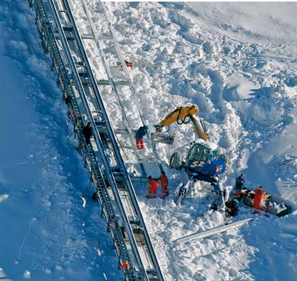
Für die Solaranlage wurde bis vor Weihnachten unter schwierigen Bedingungen gearbeitet
