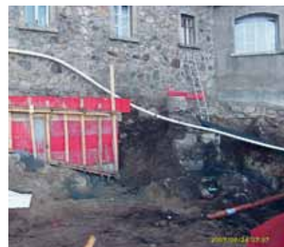
Das bestehende Hotel wurde zum Teil unterfangen
