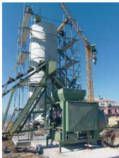
Unsere Betonanlage, bevor wir sie Frostbeständig einpackten
