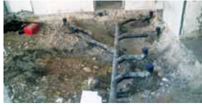
Neue Leitungen wurden verlegt
