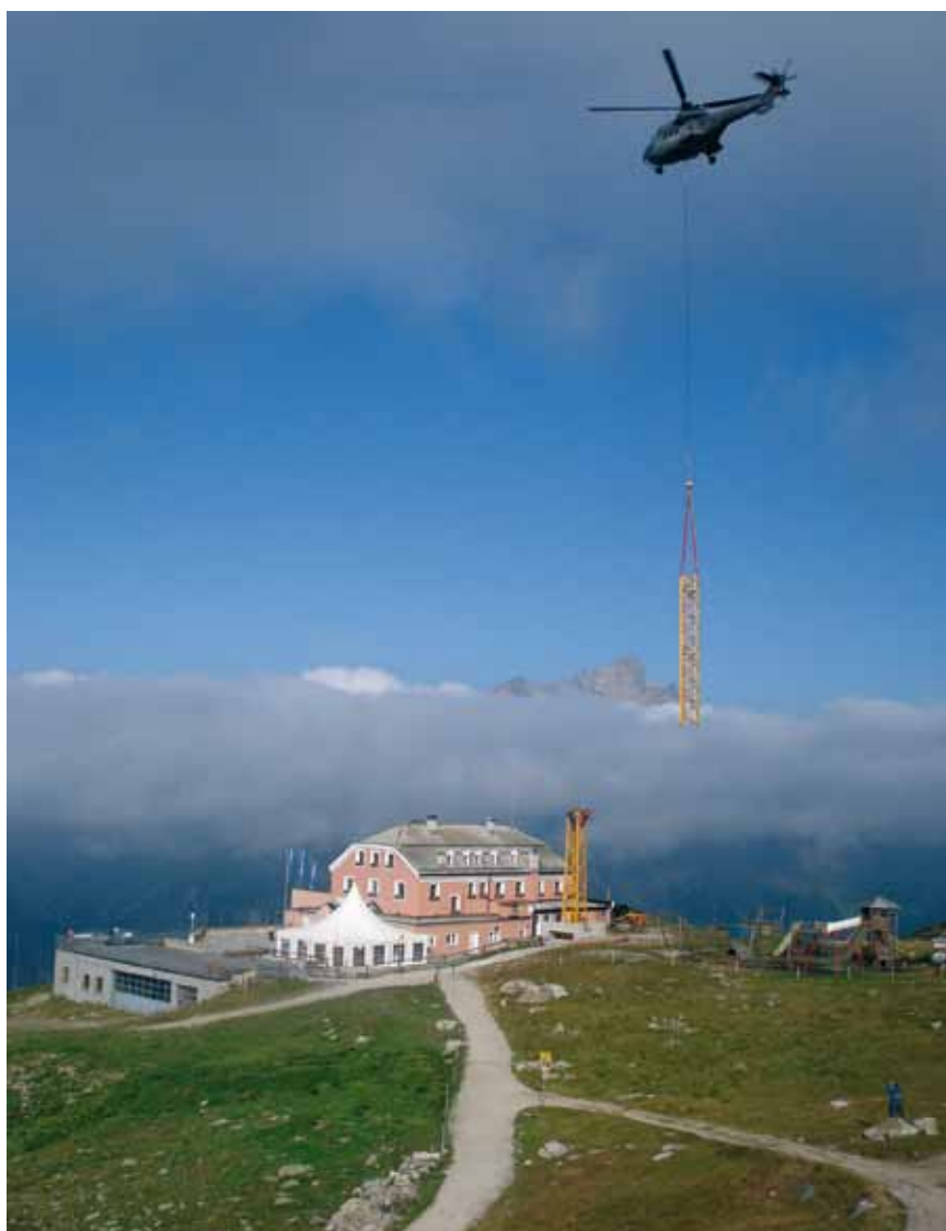
Am 24./25. August 2009 stellte der Superpuma der Firma Eagle Helikopter in Rekordzeit unseren Kran
