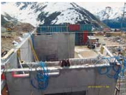
Der Küchenanbau entsteht
