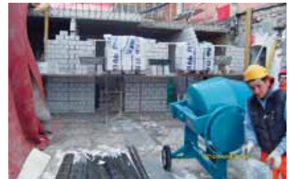
Es wurde nicht nur Beton verbaut
