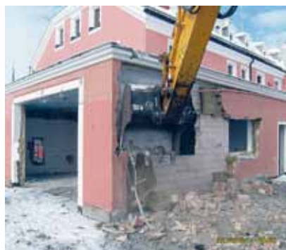
Der Abbruch kann beginnen
