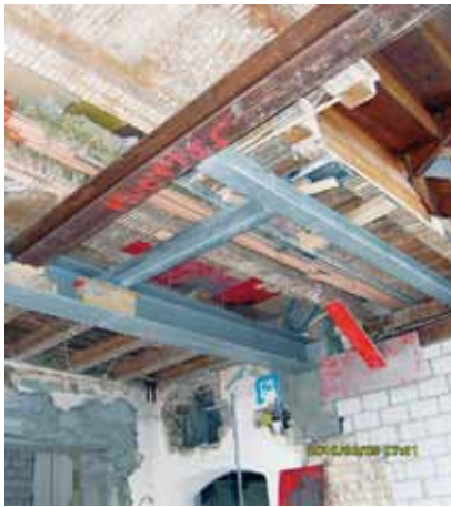
Mit Stahlträgern wurde die Holzkonstruktion abgefangen
