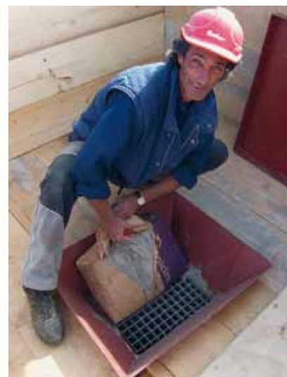
In diesen Schlitz wurden insgesamt 22'368 Säcke Zement eingefüllt. Im Bild der Chefpolier Dario Giudici beim Probe-Einfüllen.
