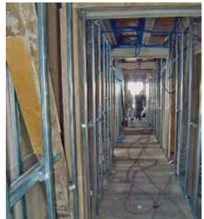
Die Zimmer wurden in Leichtbau erstellt
