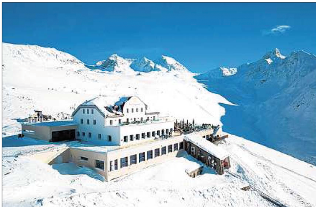
Vorbildliches Gebäude: Das «Romantik-Hotel Muottas Muragl» produziert in einem Jahr mehr Strom, als für den täglichen Gebrauch benötigt wird. (zVg)
