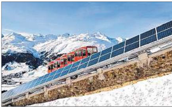
Positive Energiebilanz: Dank den Solaranlagen auf Muottas Muragl wird mehr Energie produziert als verbraucht. (zVg)
