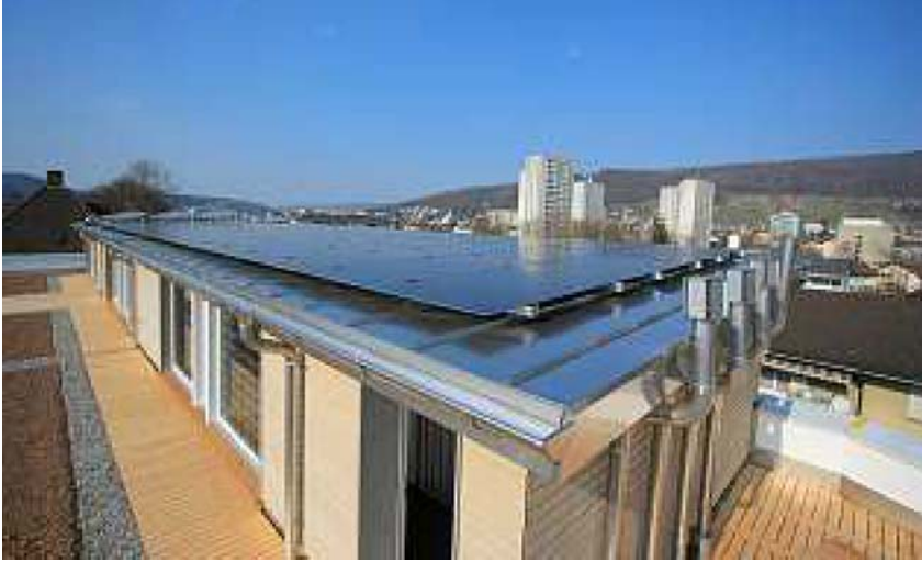
Minergie-P-Sanierung: Mehrfamilienhaus STWEG, Wettingen AG.
