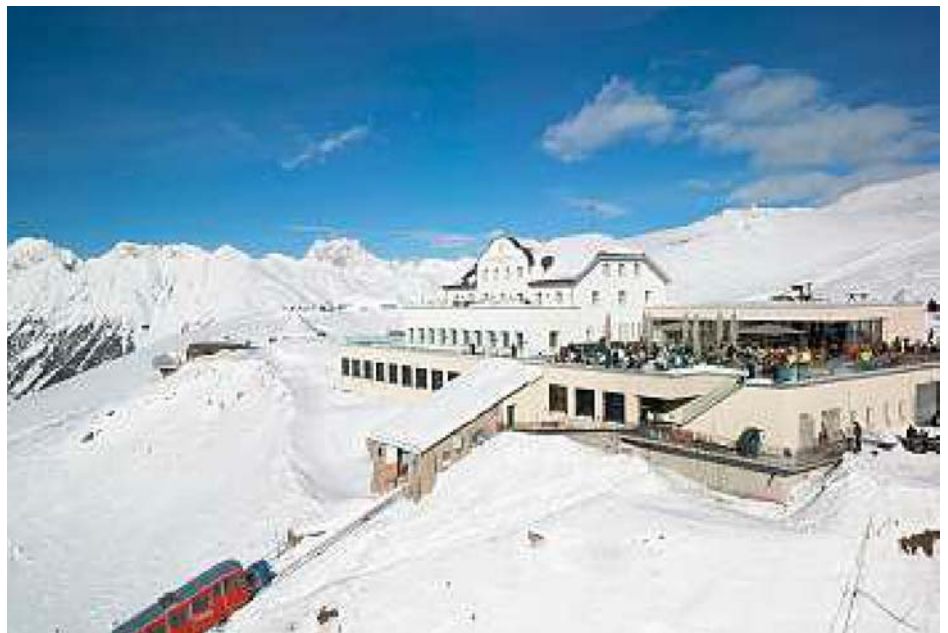
PlusEnergie-Hotel Muottas Muragl, Samedan GR.
