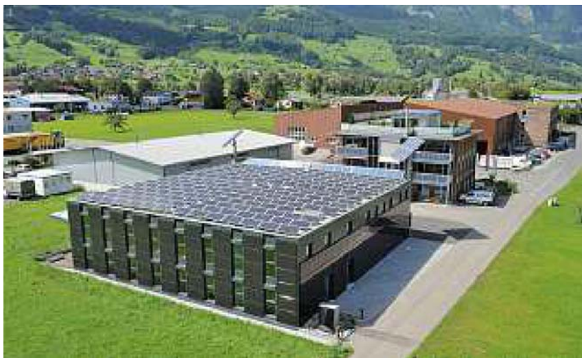
Solarer PlusEnergieBau Heizplan AG, Gams SG.
