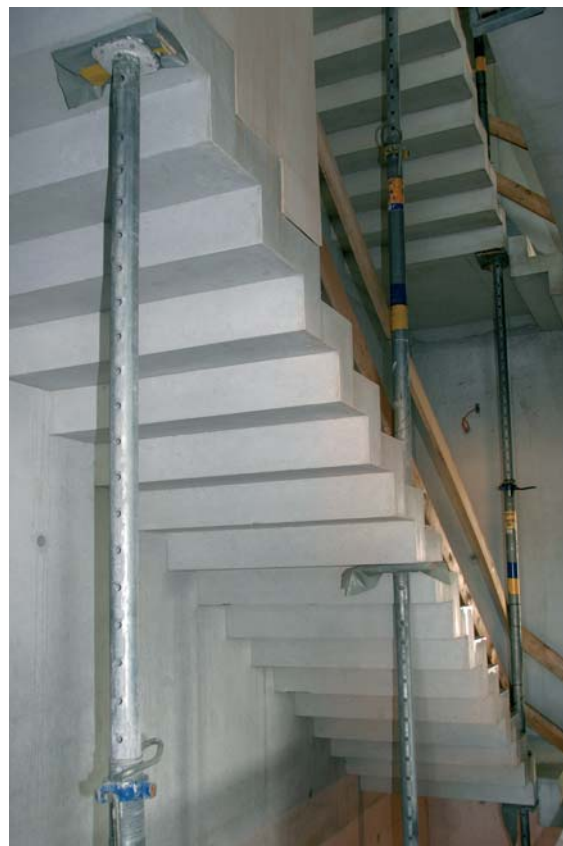
Die Treppen bestehen trotz minimaler Stärke und scharfer Kanten aus Ortbeton
