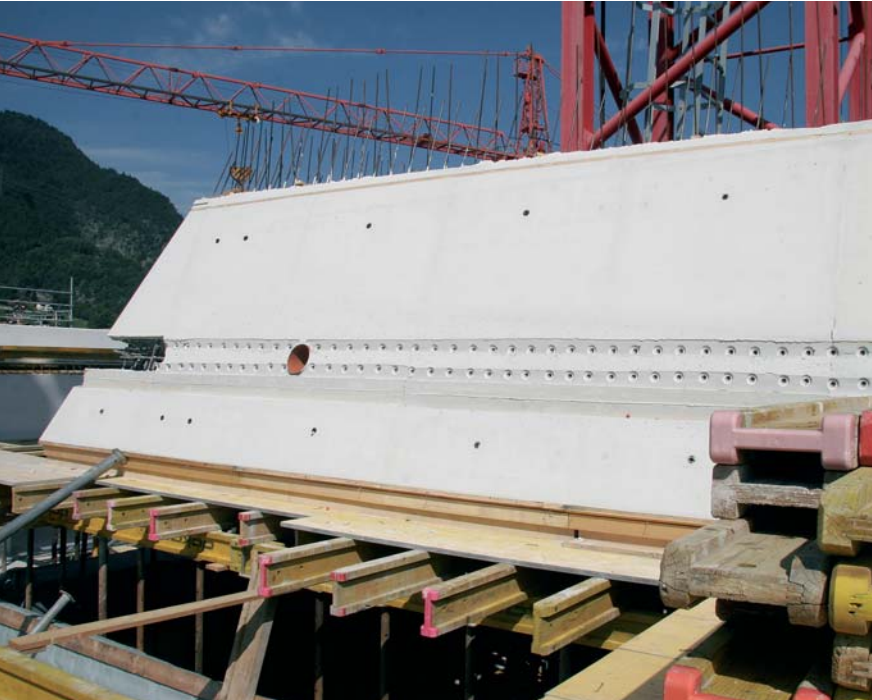
Die Brüstung des obersten Geschosses. Die Deckenbewehrung wird eingeschraubt. In die Aussparung der Eckbereiche greift später die Schubbewehrung
