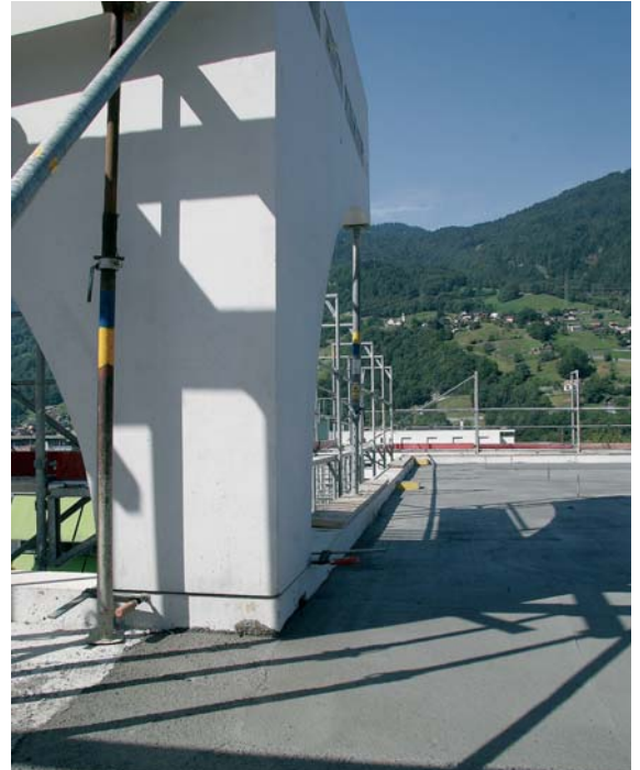
Die Elemente werden genau justiert und bis zum Einbau der Decke verstrebt und gestützt
