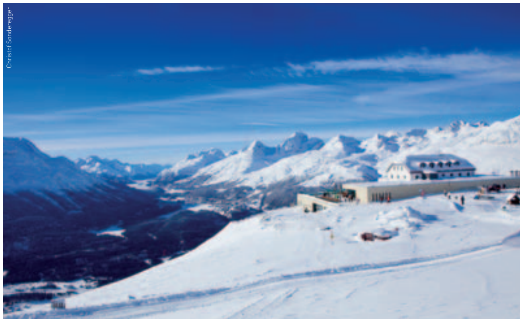
Obwohl die mittlere Jahrestemperatur bei minus 1°C liegt, reichen Sonne und Erdwärme aus, um das neu renovierte und erweiterte Hotel Muottas Muragl autark mit Heizwärme und Warmwasser zu versorgen.
