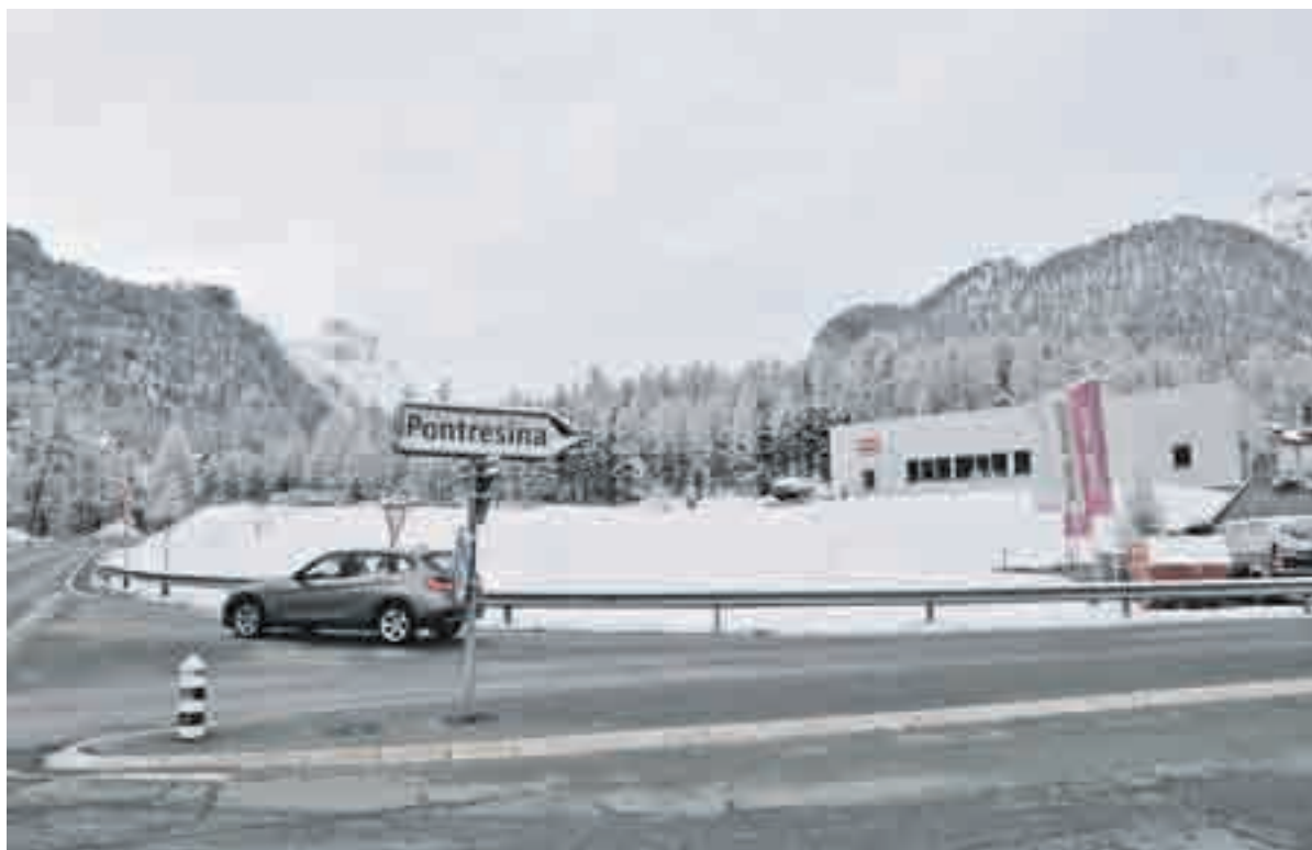
Heute befinden sich auf dem Gebiet Gitögla in Pontresina eine Wiese, eine Autogarage und öffentliche Parkplätze. Dereinst soll hier ein modernes Wohn- und Gewerbezentrum entstehen.
