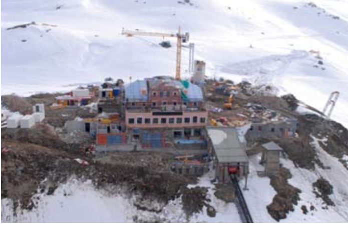
Die Baustelle des Hotels
