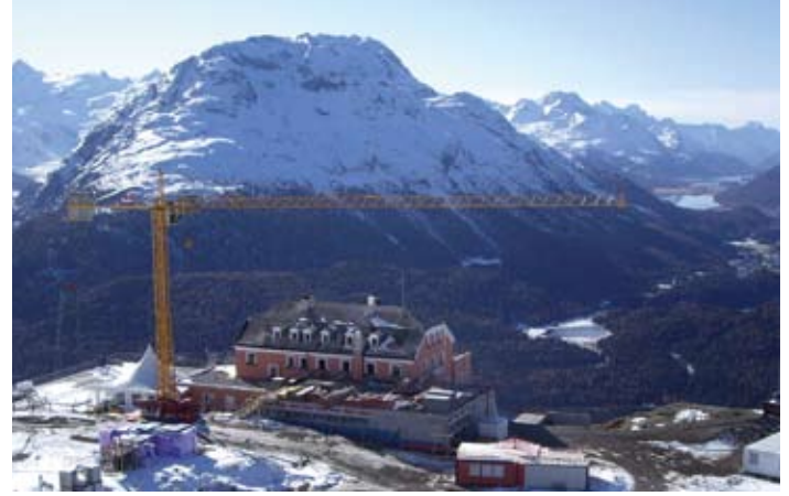
Der Hotelbau macht Fortschritte
