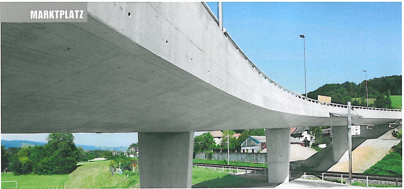
Die Brücke Schachen Holderbank wurde mit Holcim «Robusto» erstellt.
