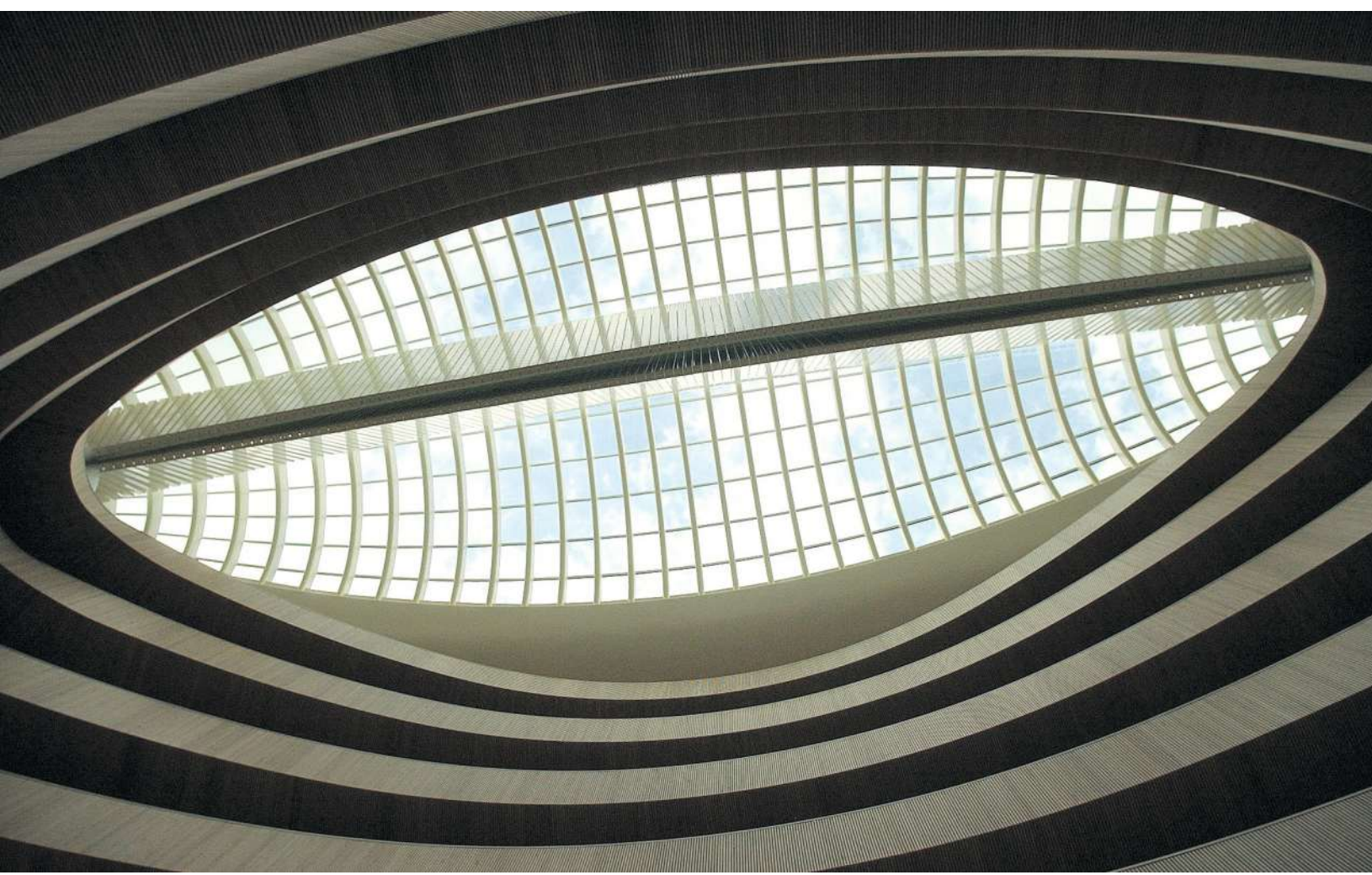
Zusammenklang von Architektur und Ingenieurtechnik – Santiago Calatravas rechtswissenschaftliche Bibliothek der Universität Zürich.
