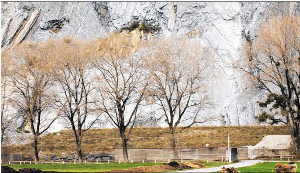
Am Fusse der Felswand kommt das Solarkraftwerk zu stehen.
