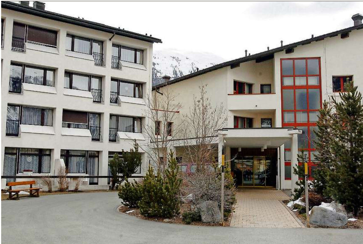
Nicht mehr zeitgemäss: In das Pflegeheim Promulins in Samedan sollen knapp 30 Millionen Franken investiert werden
