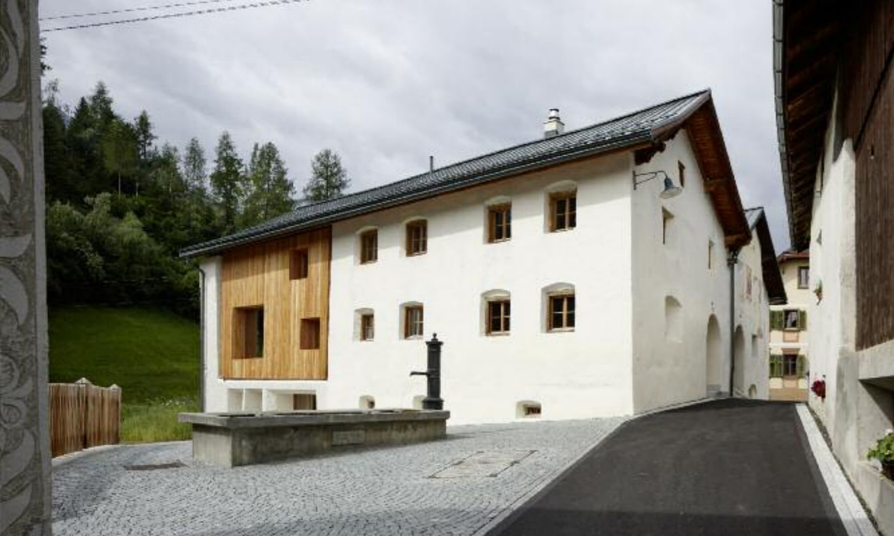
Florins besteht aus fünf historischen Häusern und einem Dorfbrunnen. Ansicht des umgebauten Bauernhauses von Nordosten.
