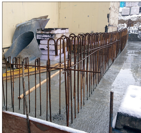
Die Mauer des Haupteingangs nimmt Formen an.
