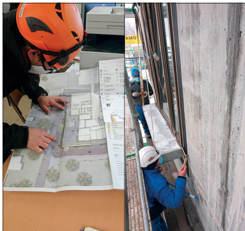
Bauleiter Raffael Forrer von der Firma Fanzun studiert die Pläne.
