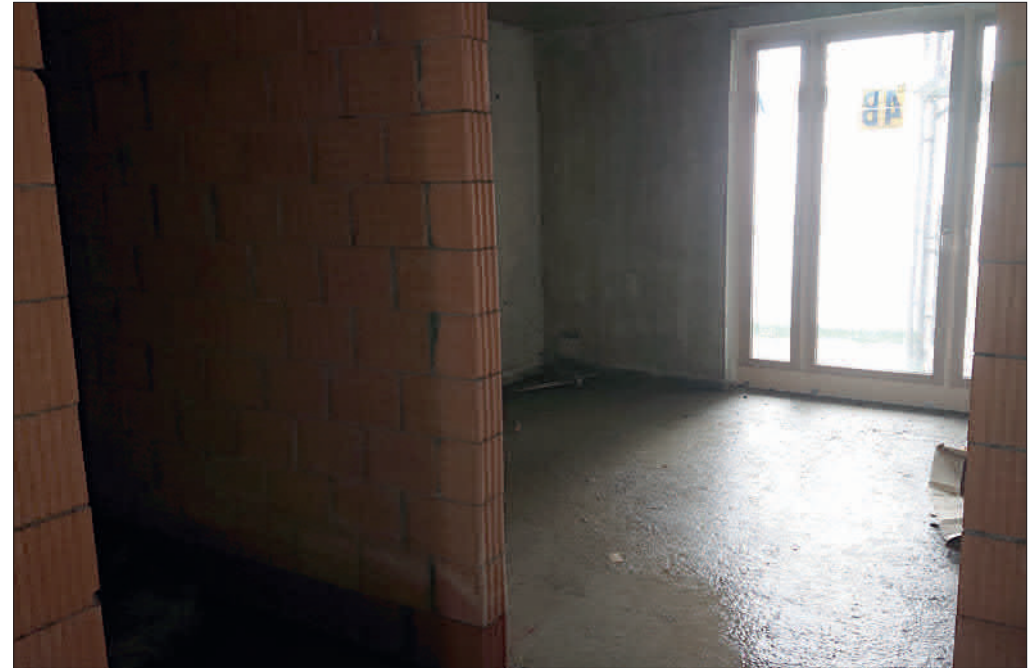
Die Bewohnerzimmer sind schon gemauert.
