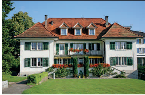
Das Gründergebäude vor dem Abriss 2019.
