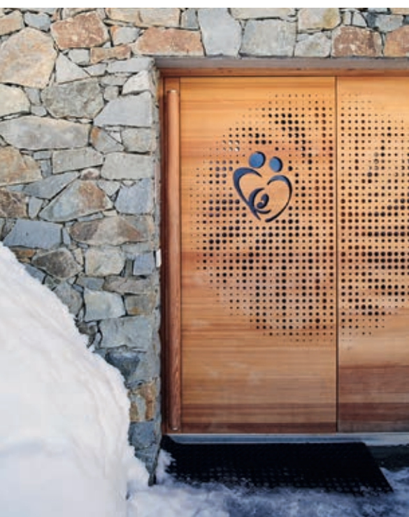
Eine Haustür aus Glas oder aus Holz? Als Kompromiss entstand die perforierte Holztafel auf der Glastür, die aussen mit den Fenstern harmonisiert und innen ein Lichtspiel erzeugt.
