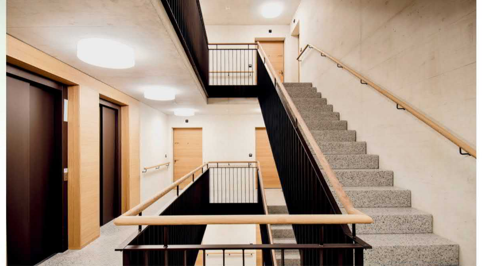
Das ganze Haus ist durchgehend rollstuhlgängig. Die wohnliche und helle Atmosphäre im Treppenhaus ist durch die Materialkombination vom Kalksteinbeton, Terrazzo und Eichenelementen erschafft.
