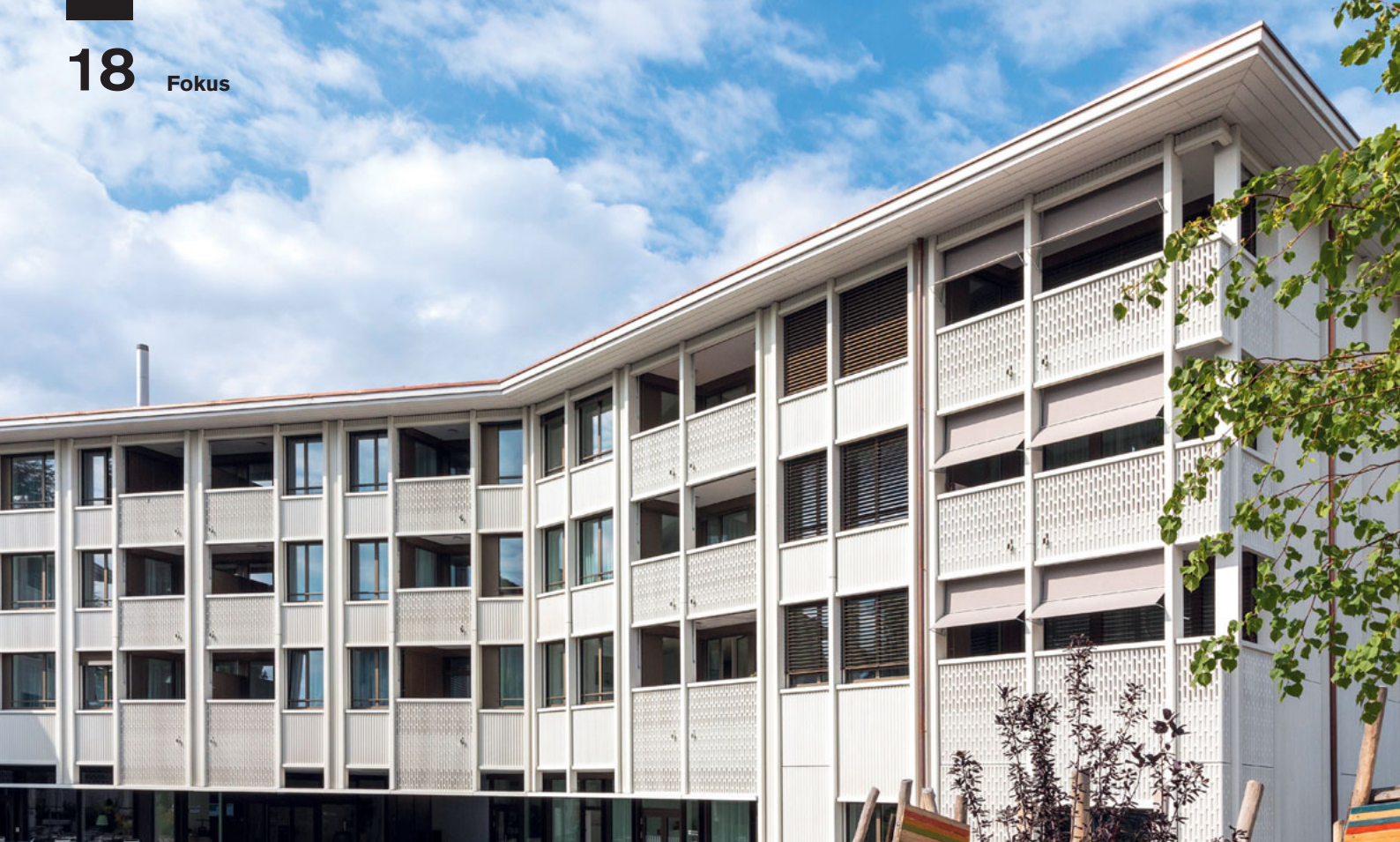
Das Alterszentrum Gehren: ein Haus für alle Generationen.
