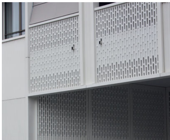
Die Fassade aus vorfabrizierten, glasfaserarmierten Feinbetonelementen ist charakteristisch für diesen Neubau.
